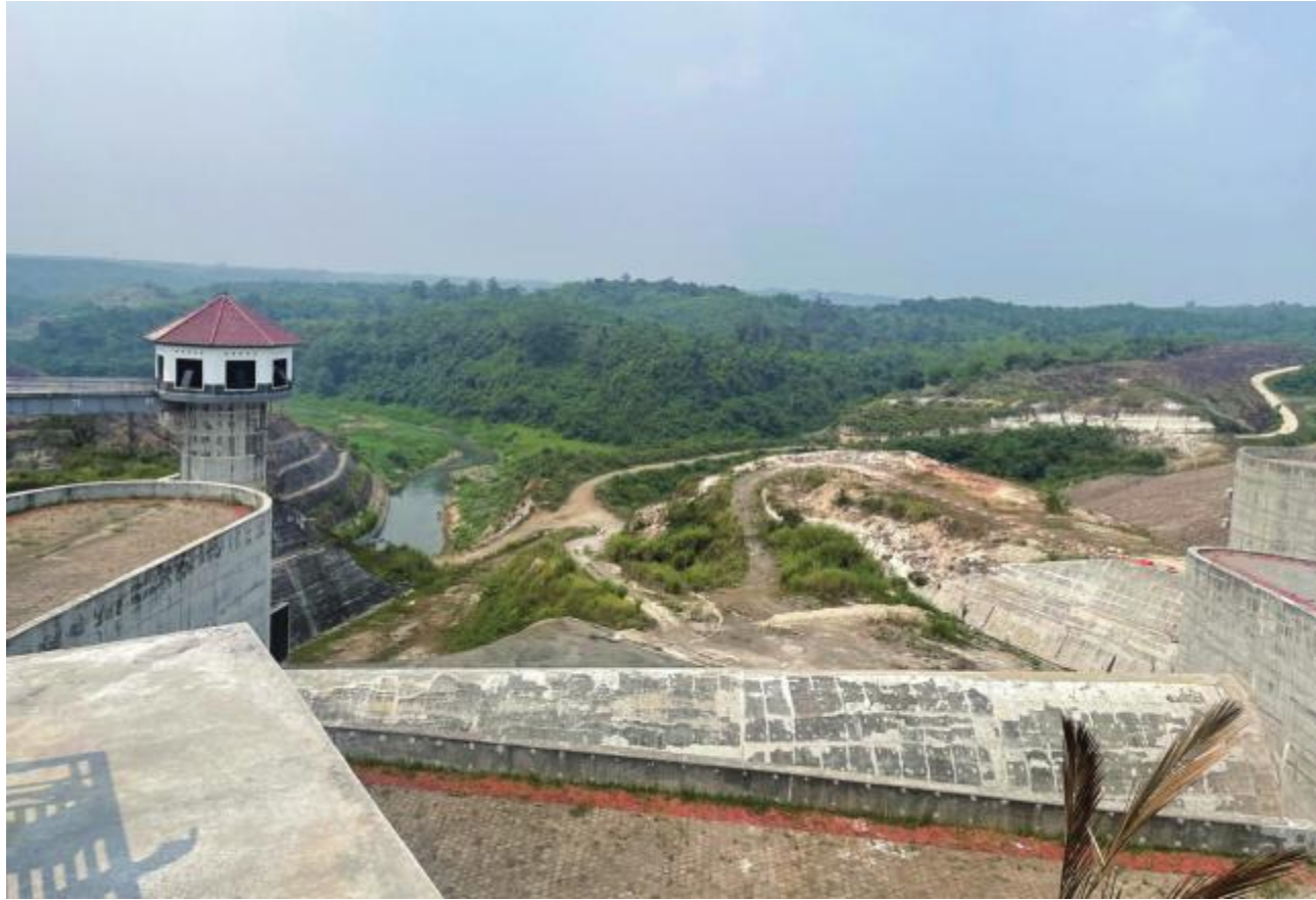
2023.08.30 건설 중인 카리안댐 전경
