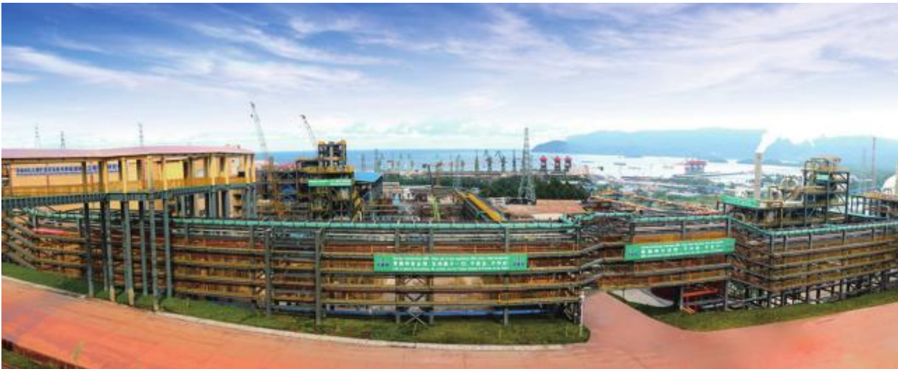
프로젝트펀드를 통해 지분투자를 완료한 인도네시아 니켈제련소 건설 현장
