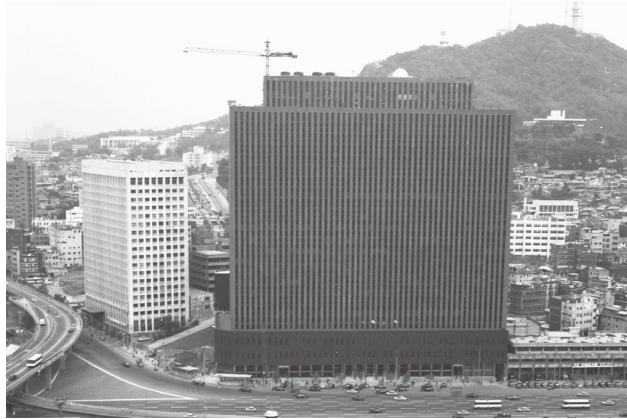
본점 소재지로 결정된 대우센터빌딩 전경
