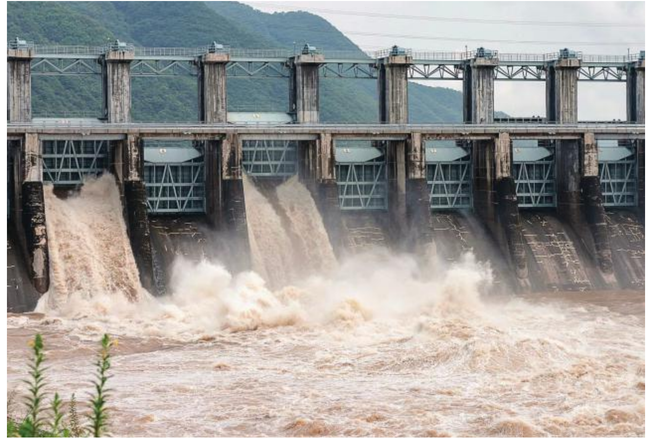
네팔 UT-1 수력발전소 전경
