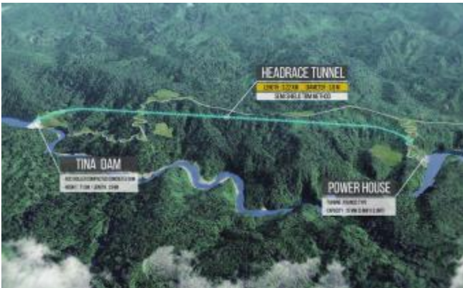
PPP사업 형태의 모범사례가 된 솔로몬군도 티나강 수력발전사업
